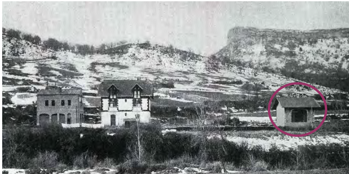
Antoñana.—Subcentral de transformación, edificio de viajeros y muelle.
